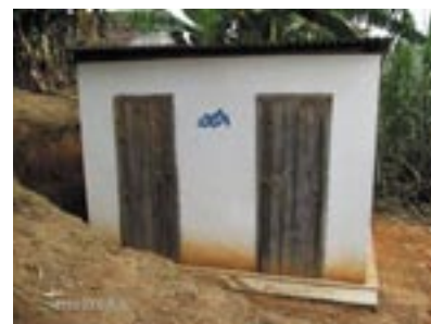
Latrines scolaires de Mandritsara
