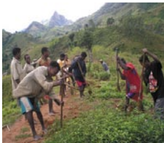
Travaux de terrassement réalisés par les habitants d'un village
