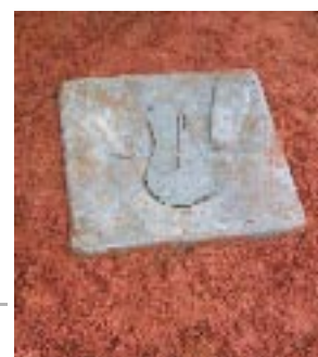
Dalle Sanplat en cours d'installation
