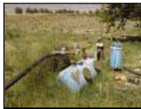
Ancien filtre à sable
