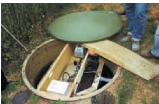
Aërobe biofilter of oxidatiebed (zie A2, pagina 68).
