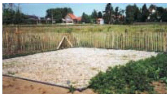
Een percolatierietveld in aanbouw (zie B.1. p. 69).
