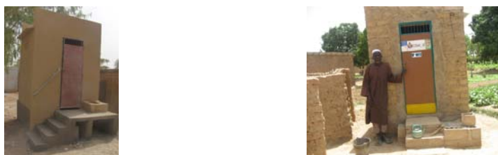
Photo 1 : latrines construites par le projet
