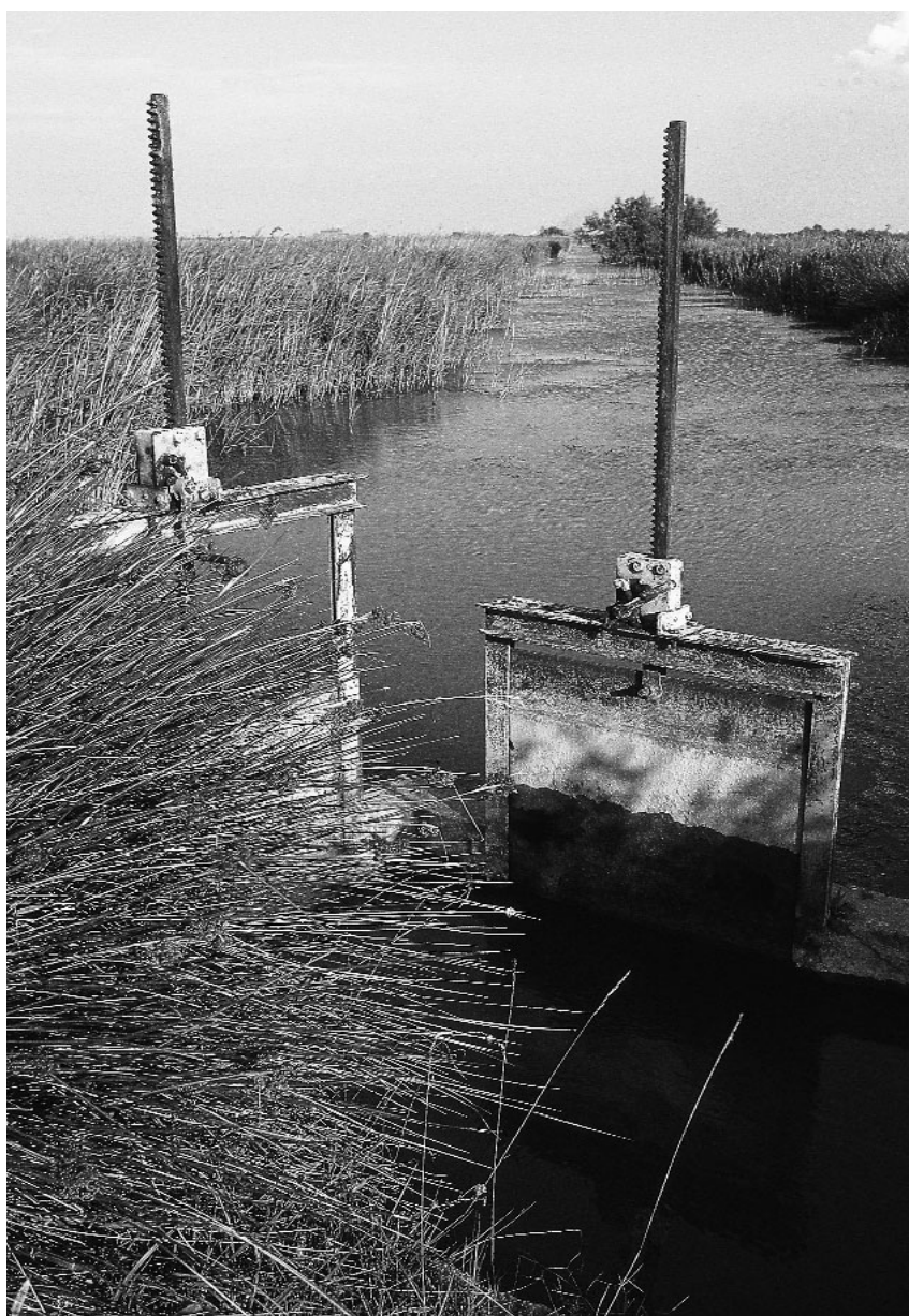
Gérer des zones humides faisant partie intégrante d'un bassin fluvial suppose parfois de régler les flux afin de leur garantir des apports d'eau adéquats pour entretenir les fonctions écologiques.
