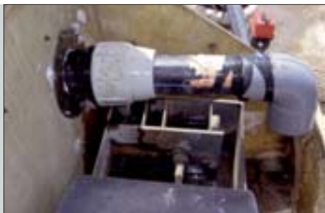
Doseur de sulfate d'alumine
