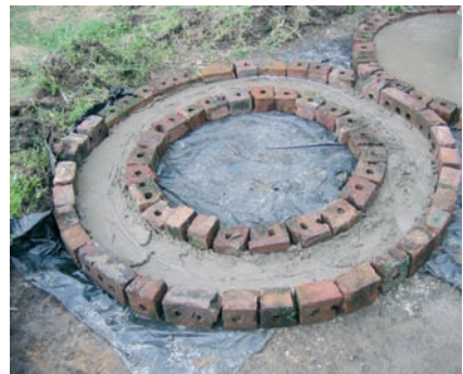
Photo 3-30 : Mélange de béton dans le moule
