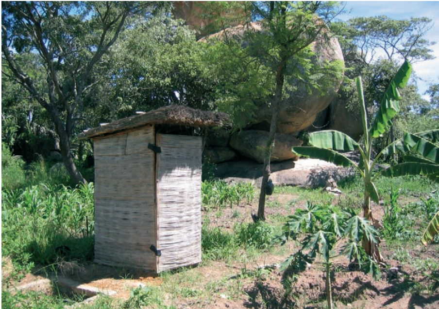
Photo 13-1 : Eco-latrine à Ruwa, au Zimbabwe
