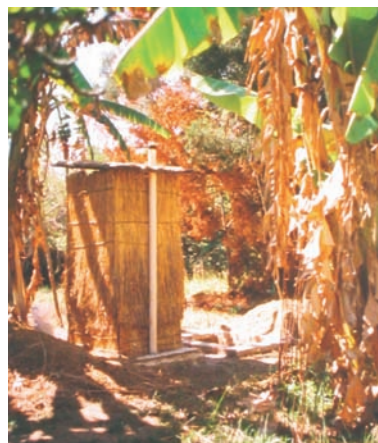
Photo 4-16 : La Fossa alterna avec des murs d'herbes
