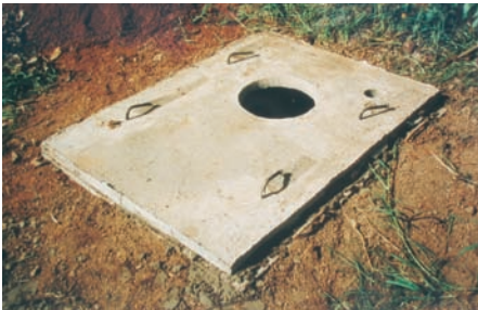
Photo 4-13 : Pose de la dalle de béton
