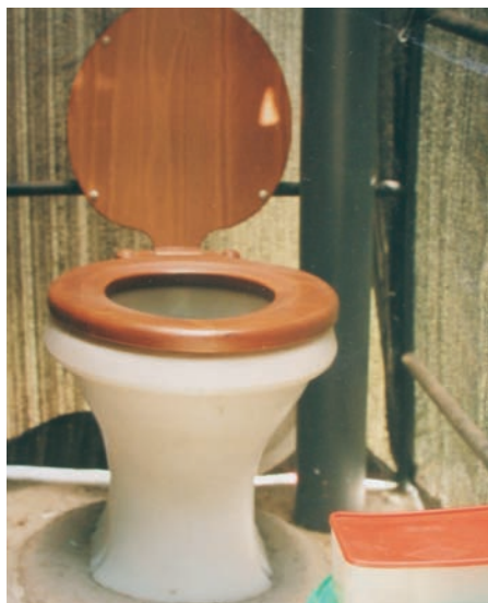
Photo 6-35 : Siège à séparation d'urines avec un joli bord et couvercle en bois
