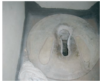
Photo 4-4 : L'intérieur de la structure permanente
