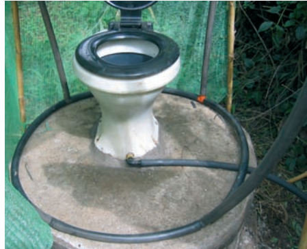
Photo 7-8: Le tuyau de déviation des urines attaché à la base d'un siège.
