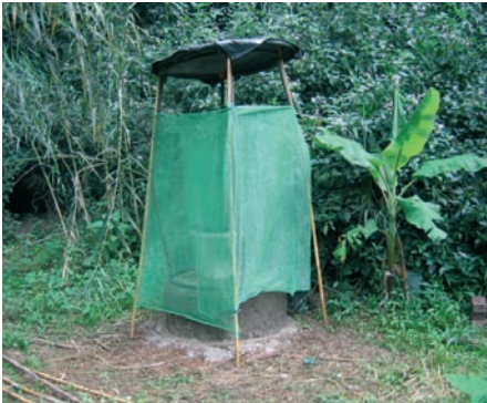
Photo 7-7 : Superstructure autour d'une latrine améliorée.
