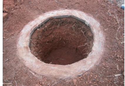
Photo 3-46 : Une fosse creusée à l'intérieur du soubassement.
