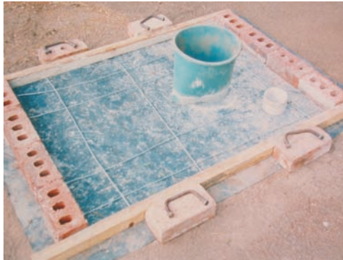
Photo 4-6 : Un moule de dalle fait avec des briques et du bois.
