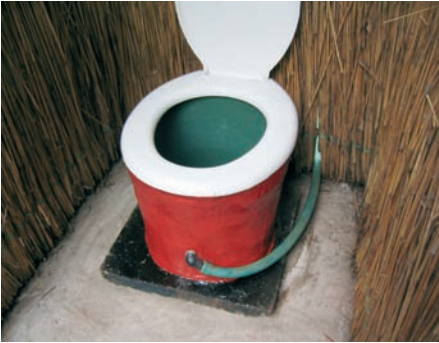
Photo 6-31 Siège à séparation d'urines installée.
