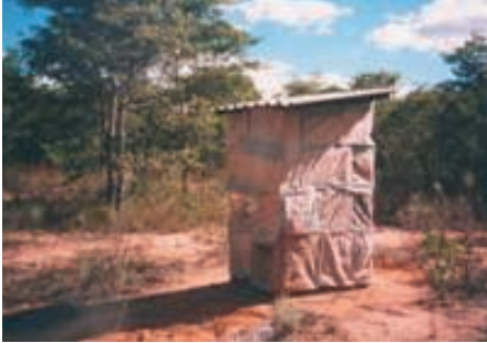
Photo 7-9 : Arborloo construit sur une dalle rectangulaire
