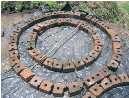
Photo 3-28 : Deux cercles de briques pour constituer le moule du soubassement.
