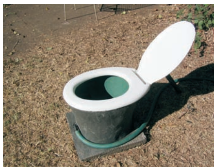
Photo 6-28 : Tuyau de canalisation d'urine, dirigé vers l'arrière de la latrine.
