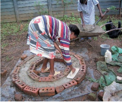
Photo 3-16 : Nivellement du béton.
