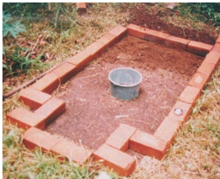
Photo 6-1 : Le coffrage de briques pour la dalle de base
