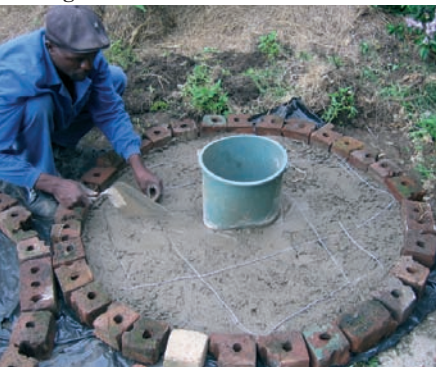
Photo 3-26 : Ajout d'armature pour renforcer.
