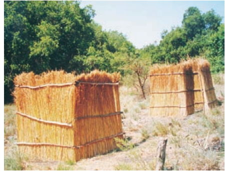
Photo 3-38 : Des superstructures sans toit.
