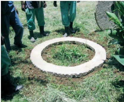
Photo 3-35: Placement du soubassement de béton
