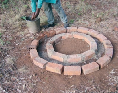
Photo 3-43 : Utilisation de briques pour faire le soubassement.
