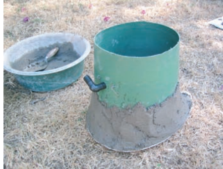
Photo 6-20 : Béton ajouté à mi-hauteur du seau
