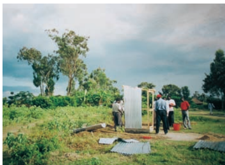
Photo 4-25 : Construction d'une structure mobile pour une Fossa alterna
