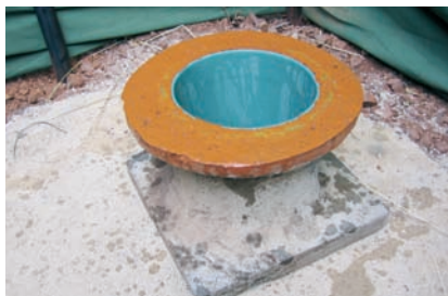
Photo 3-52 : Siège à faible coût posé sur la dalle
