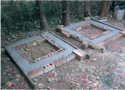
Photo 6-47 : Moulage des soubassements
