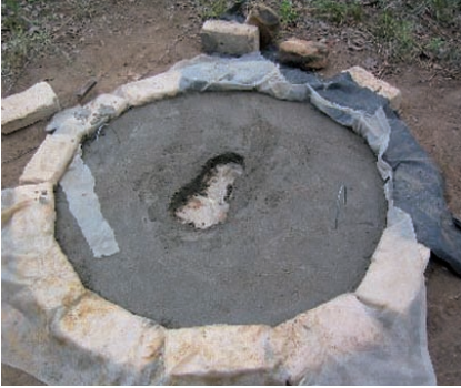
Photo 3-9 : Le moule après le retrait des briques d'insertion du trou de défécation.
