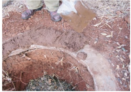
Photo 3-48 : Mortier étalé sur le soubassement.
