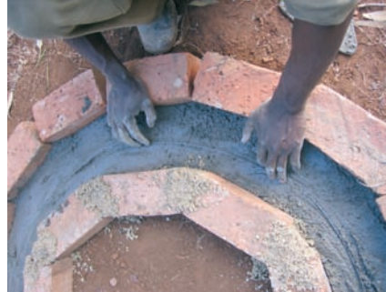
Photo 3-44 : Ajout de fils de fer pour le renforcement.
