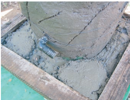
Photo 6-23 : Fil de fer supplémentaire pour le renforcement
