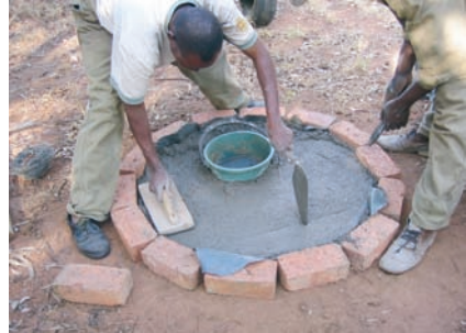
Photo 3-42 : Nivellement du mélange de béton
