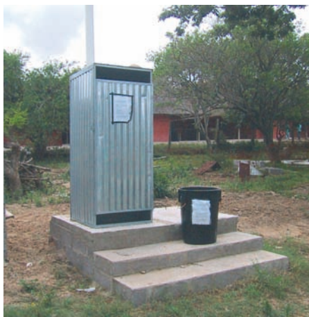
Photo 4-27 : Une Fossa alterna avec une structure métallique
