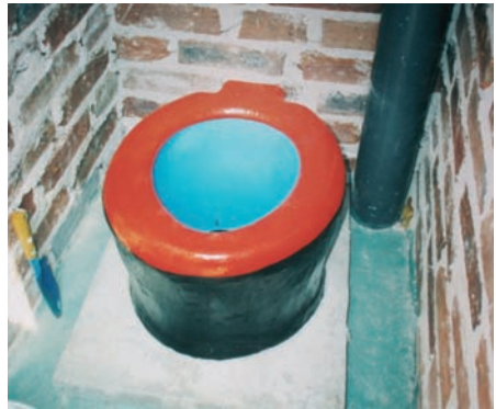
Photo 5-6 : Siège de béton finalisé
