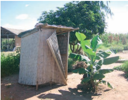
Photo 3-39 : Superstructure en matériaux locaux.
