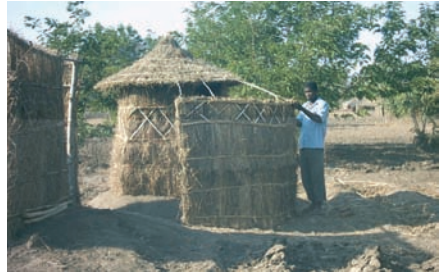
Photo 3-54 : Une belle structure fonctionnelle
