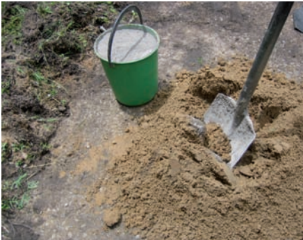
Photo 3-24 : Mélange du ciment au sable mélange
