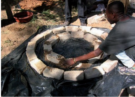
Photo 3-13 : Un moule de brique sur une feuille de plastique.
