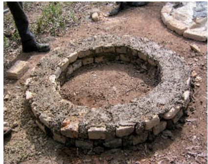
Photo 3-12 : Finalisation du soubassement en briques.
