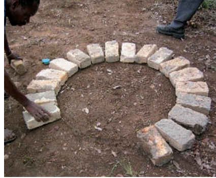
Photo 3-10 : Réalisation du soubassement en briques.
