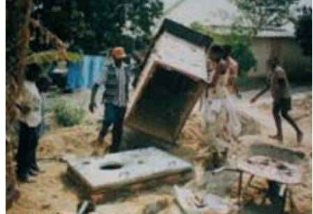
Photo 7-10 : La Fossa alterna construite sur une dalle rectangulaire
