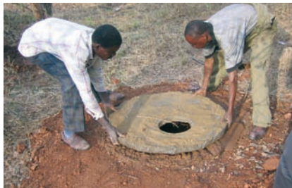
Photo 3-49 : Pose de la dalle sur le soubassement
