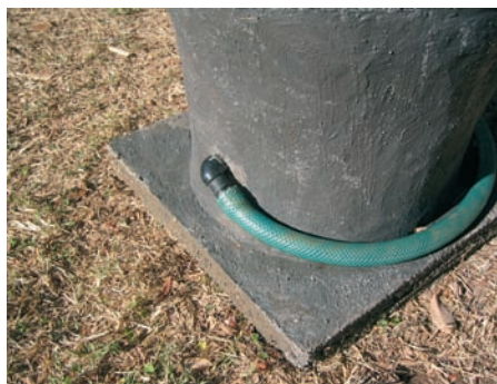
Photo 6-27 : Tuyau de canalisation de l'urine attaché.
