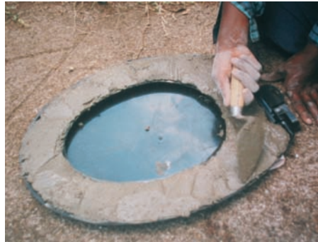
Photo 5-8: Le siège en plastique rempli de béton.
