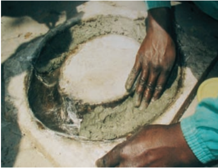
Photo 5-3 : Ajout de béton au moule du siège
