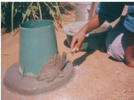
Photo 5-1 : Construction du siège à faible coût.
