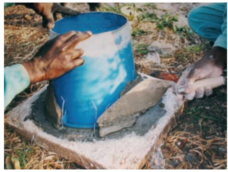
Photo 5-4 : Application du ciment sur les parois du seau
