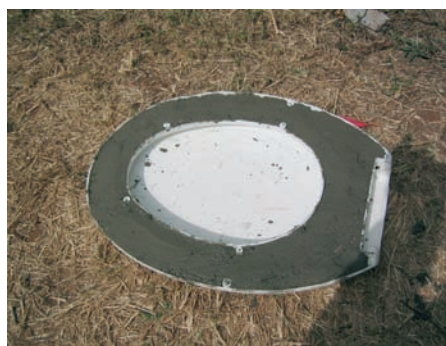
Photo 6-17 : Béton ajouté au siège de latrine
