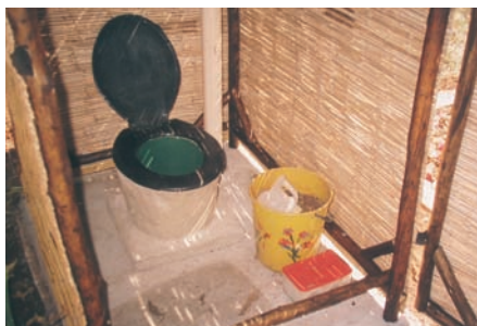
Photo 4-18 : L'intérieur d'une Fossa alterna équipée d'un siège
