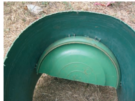
Photo 6-12 : La base découpée est attachée avec du fil de fer
