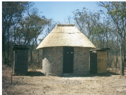
Photo 4-26: Une Fossa alterna avec une structure permanente en chaume et en briques
