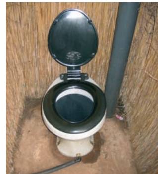
Photo 7-12 : La Fossa Alterna améliorée avec un siège à séparation d'urines
