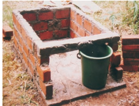
Photo 6-4 : Vérification de la taille de l'entrée de la fosse
