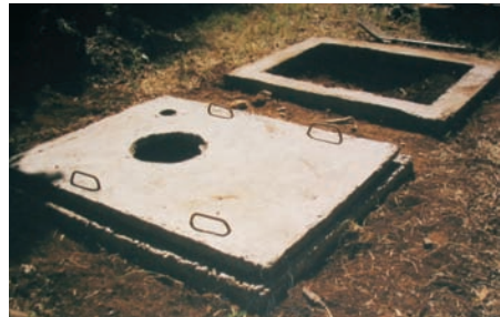
Photo 4-14: Les fosses finalisées de la latrine à compost à double fosse
