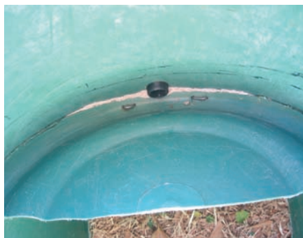
Photo 6-26 : La partie supérieure du séparateur est scellée
