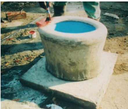
Photo 5-5 : Peinture du siège de béton
