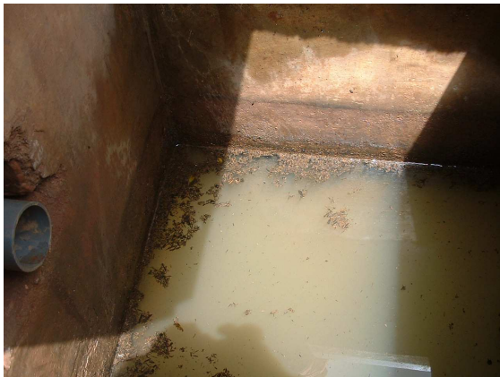
Intérieur de la chambre de départ avec dessableur du captage n°1. La chambre n'est plus alimentée
